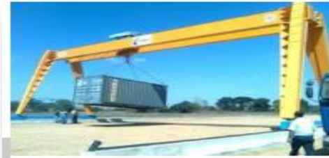
Resim 4: Köprü Üzerinde Yürüyen Vinç
